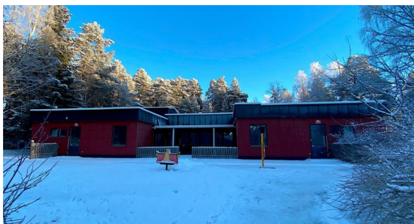
Bilden visar den gamla förskolebyggnaden som nu har rivits.
