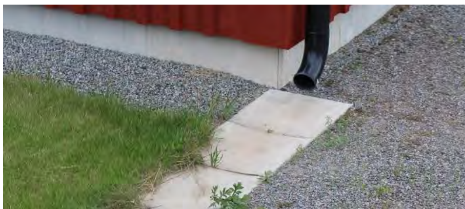
Figur 14. Stuprör med utkastare. Skador på grund av erosion hindras och diffus avrinning främjas via plattsättningen.
