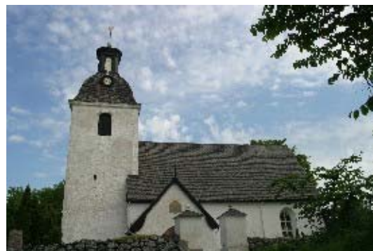
Byggt på 1200-talet på grunden till en gammal träkyrka
